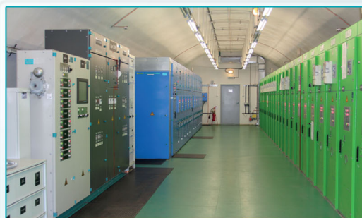
Машинный зал на станции метрополитена "Международная" (Санкт-Петербург)
