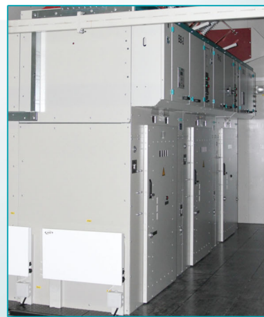
Функциональные блоки распределительного устройства 35 кВ Одностороннее обслуживание, внутренняя установка. Выполнены на базе шкафов серии "1С-35" или аналогичных. Ток главных цепей блока до 2000 А. Количество шкафов в блоке – до 3 шт.
