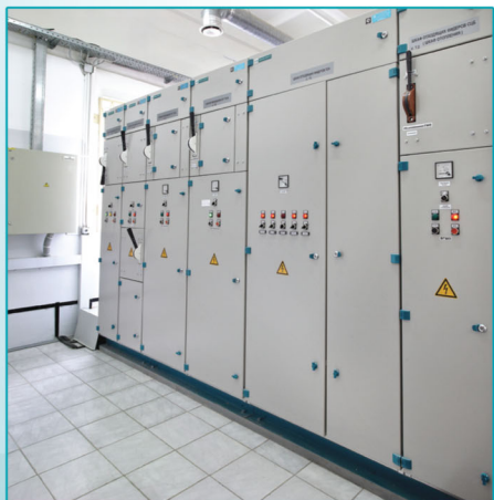
Низковольтное комплектное устройство Одностороннее обслуживание, номинальный переменный ток главных цепей до 2500 А, номинальное напряжение переменного тока до 0,66 кВ, номинальный постоянный ток главных цепей до 630 А, номинальное напряжение постоянного тока до 220 В.
